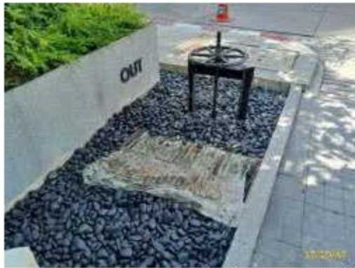
ประตูกั้นน้ำบริเวณบ่อพักน้ำสุดท้ายก่อนระบายออกนอกโครงการ
