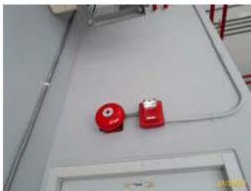
อุปกรณ์ส่งเสียงสัญญาณแบบกระดิ่งสัญญาณ
