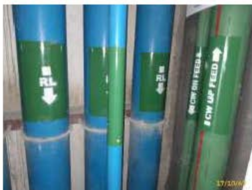
ระบบรวบรวมน้ำฝนภายในอาคาร
