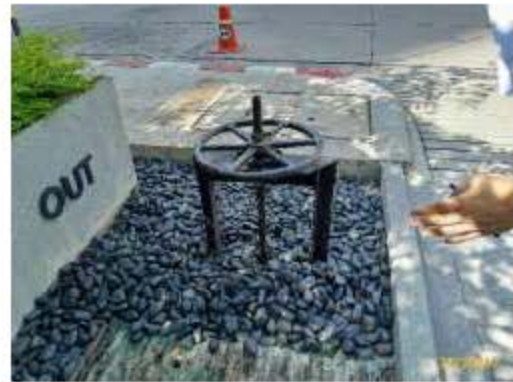
ประตูกั้นน้ำบริเวณบ่อพักน้ำสุดท้ายก่อนระบายออกนอกโครงการ
