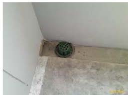
ระบบรวบรวมน้ำฝนภายในอาคาร
